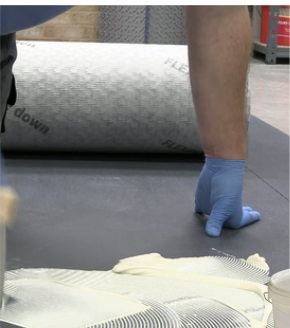
Apply ARDEX AF 200 Plus uncoupling mat adhesive
